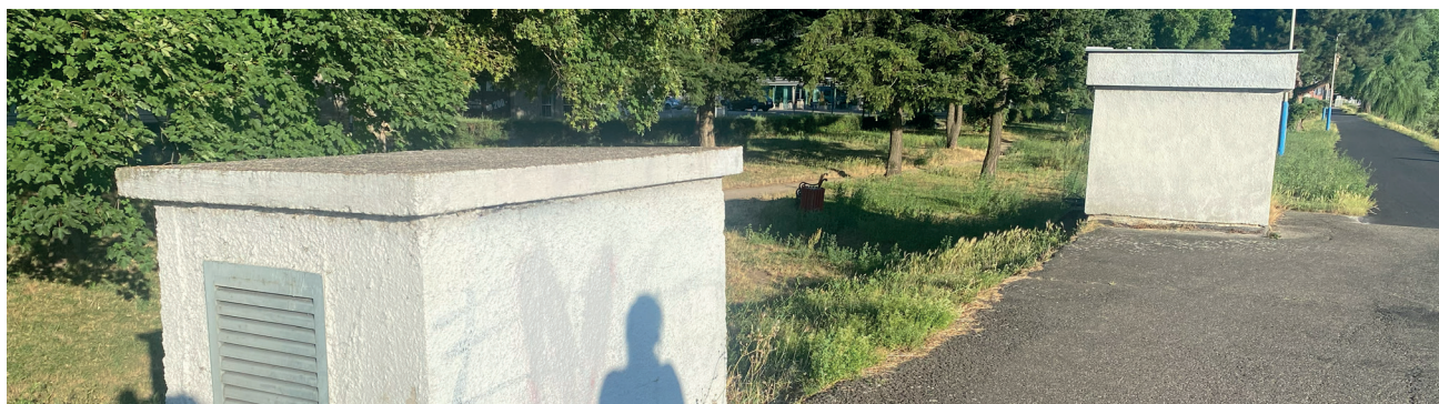
pohled na vstup do technického zázemí vodní elektrárny umístěné pod povrchem a na dělicí svah
