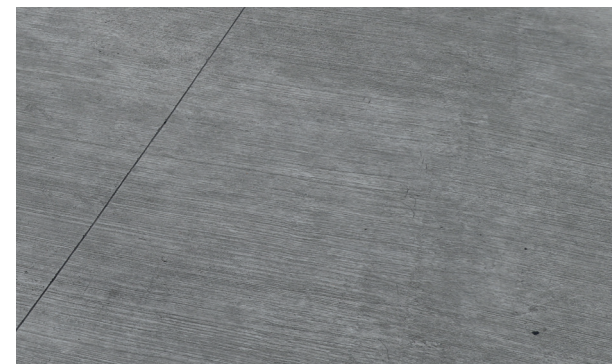
kartáčovaný beton s příčnými dilatacemi - hlavní cesta
