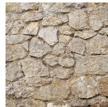
KAMENNÁ OPĚRNÁ ZEĎ
