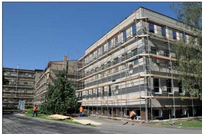
Městský úřad v Břeclavi získá nová okna a zateplení budovy, výrazně se tak sníží energetické ztráty.
