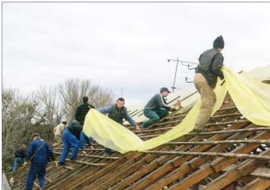
Při opravě střechy starobřeclavského kulturního domu přiložili ruku k dílu členové slováckého krúžku, fotbalisté Olympie i chasa. Na brigádě se jich sešlo téměř čtyřicet. Foto Libor Nazarčuk
