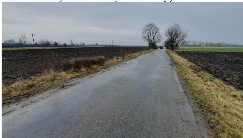
Foto 12: Pohled na jižní část koridoru pro vedení VTL plynovodu.
