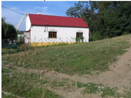
Foto 8: Pohled na plochu Oe3 ze stávající komunikace.
