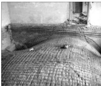
Odhalený rub klenby nad přízemím zámku byl opatřen ocelovou výztuží.
