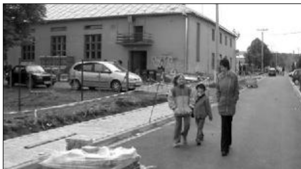
V říjnu byla dokončena také rekonstrukce komunikace Tyršův sad. Investice se vyšplhala na téměř půldruhého milionu korun.
