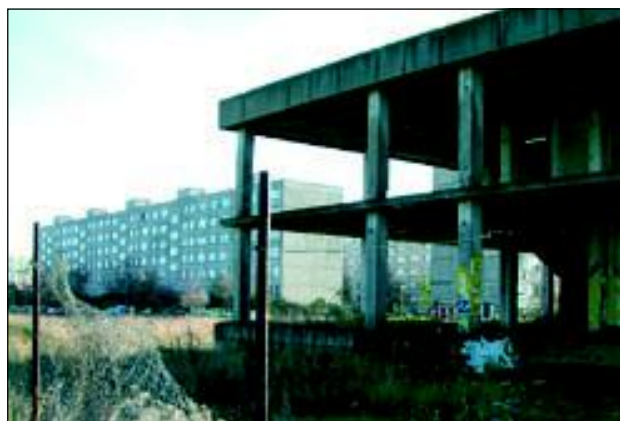
Monstrum tyčící se na největším breclavském sídlišti hodlá jeho nový majitel proměnit na polyfunkční zónu.
