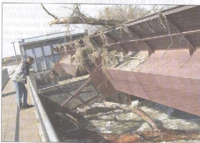
Odstranění kmenu stromu zaklíněného do stavidla paštorenského jezu si vyžádalo rozřezání zábradlí a pomoc horolezců.
