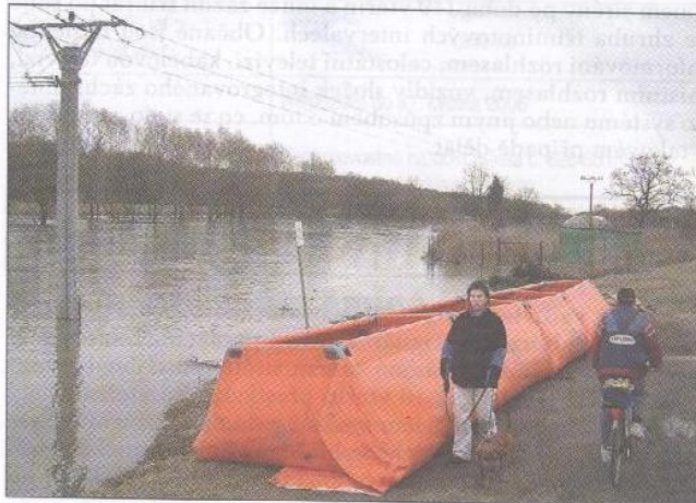
Ke zpevňování hrází posloužily protipovodňové zábrany ladenské společnosti Alba-Metal. K dispozici bylo celkem 200 metrů protipovodňových bloků, kterých bylo použito také při povodních v letech 1997 a 2002.
