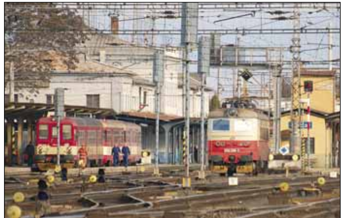
Břeclavské nádraží čeká v letošním roce rozsáhlá rekonstrukce.
