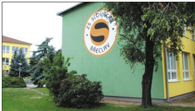
Základní škola Slovácká dostala konečně po mnoha letech nový kabát. Kromě vnější rekonstrukce bylo kompletně opraveno i sociální zařízení školy.
