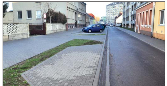
Novou kanalizaci, chodníky, parkoviště i povrch silnice dostala ulice Kupkova.
