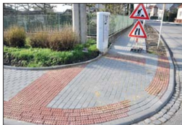
Opraveny jsou i některé chodníky a silnice ve Staré Břeclavi.
